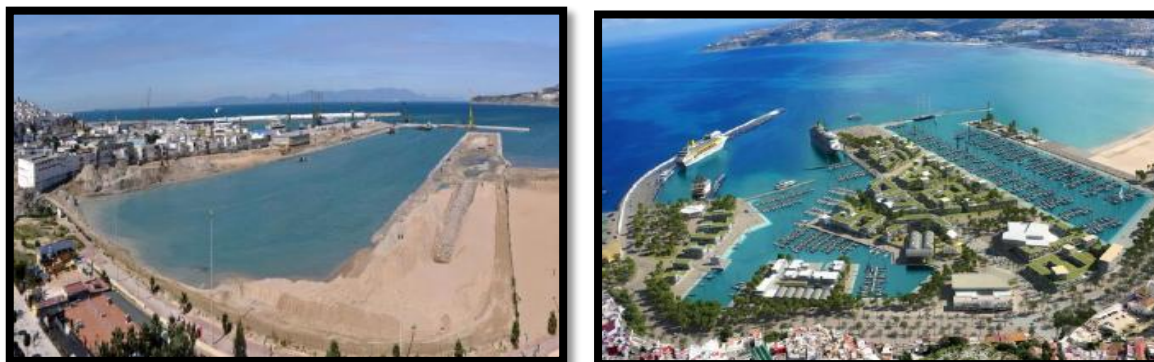
Figure 2 : Vue générale sur le port de Tanger avant et après la reconversion. (Source : www.sapt.ma)
