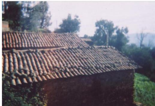
Figure 77: Couverture en tuile.
