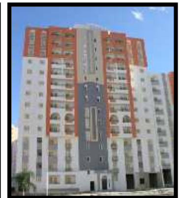
Figure 9: l'habitats collectifs ADEL à Blida villes intérieures
