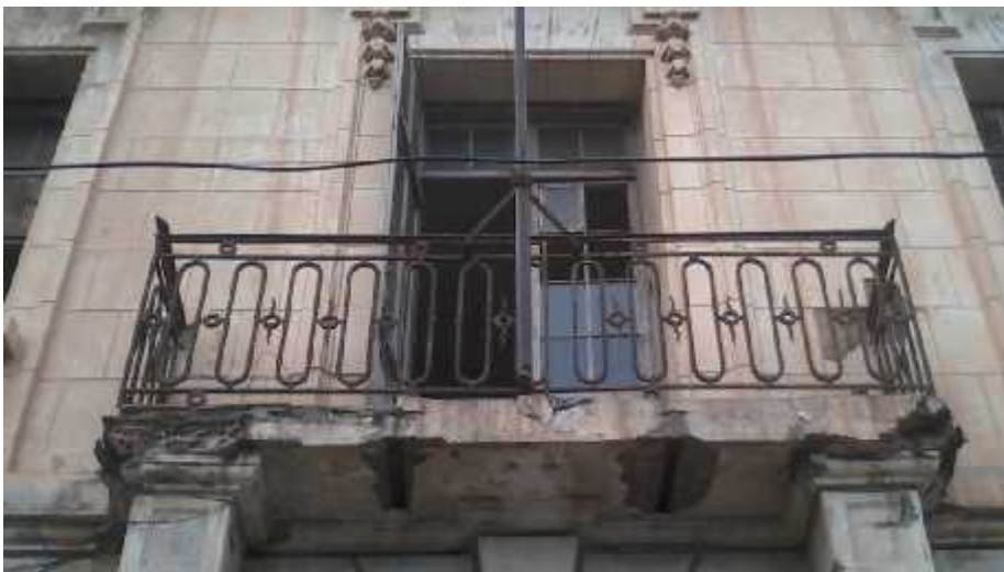
les poutrelle et les bardage en acier
