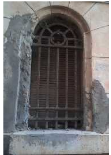
Bardage de fenêtre en acier
