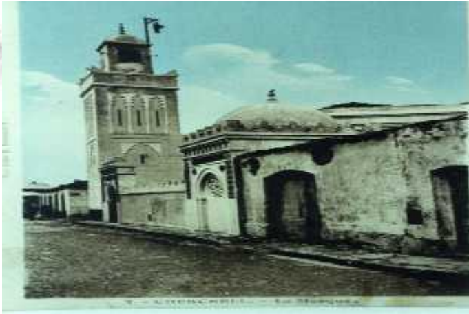
(fig 18) Mosquée du Souk : Classé le 19-10-1982
