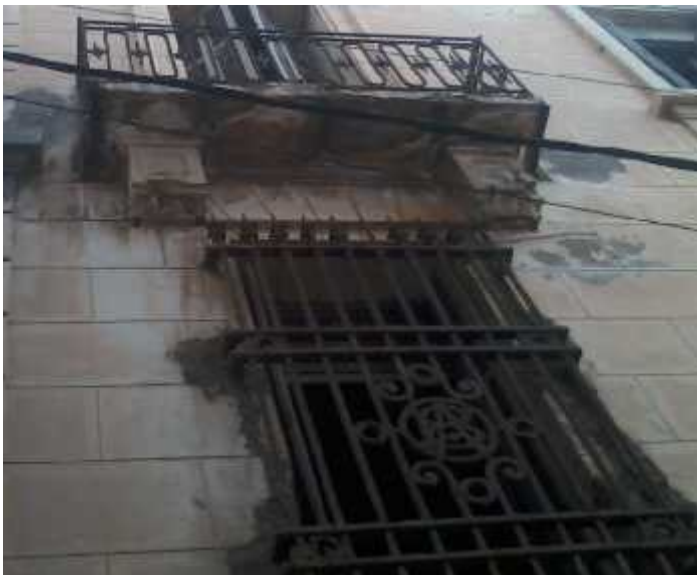
Bardage de grande fenêtre en acier
