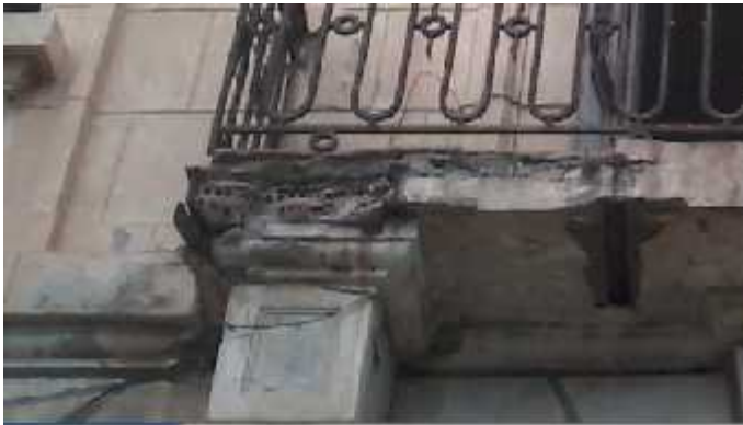
la brique dans la dalle
