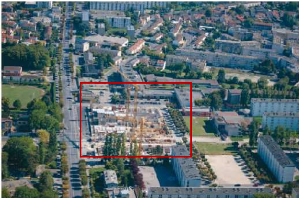
Fig. (II.6) : Quartier Croix Rouge ; Démarrage du chantier (Reims).
