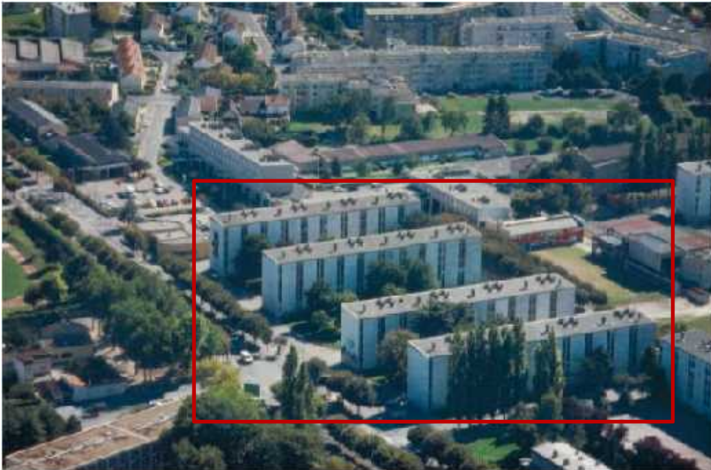
fig. (II.5) : Quartier Croix Rouge ; Immeuble démoli (Reims), avant. 19
