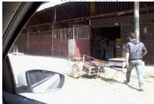
fig. (III.37) : L'état des hangars. (Source : auteur)
