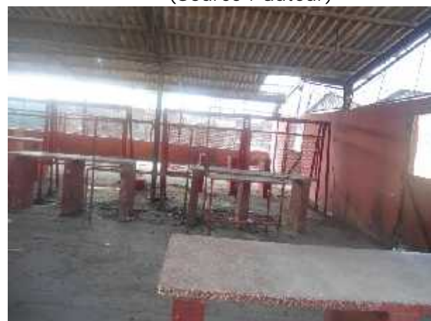
fig. (III.39) : L'abattoir à l'intérieur. (Source : auteur)
