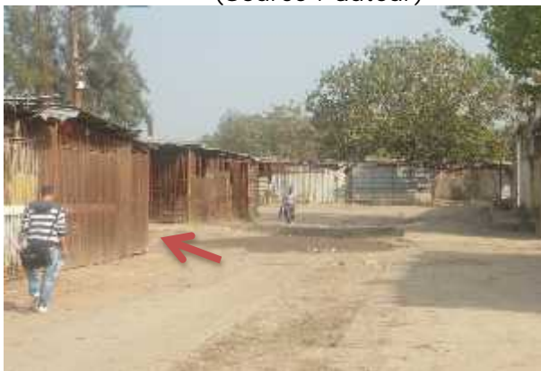
fig. (III.36) : L'état des hangars. (Source : auteur)
