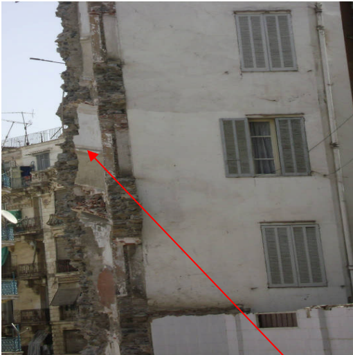
Figure 3.12 : l'état du chaînage des murs
