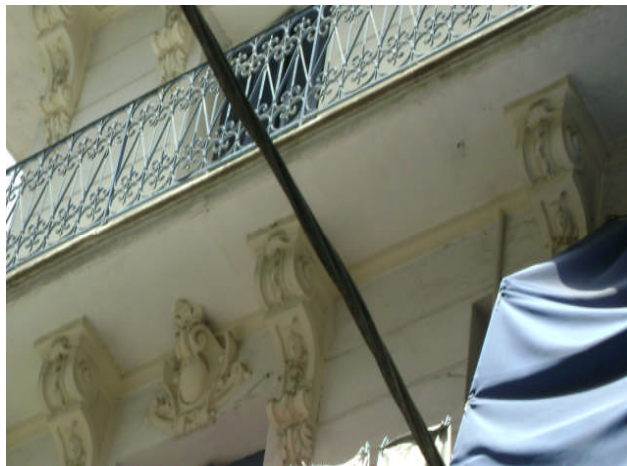
Figure 3.15 : les balcons et les gardes corps
