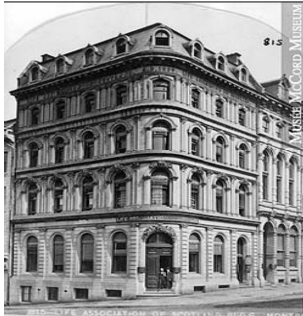
Figure 1.7: Montréal 1870, Great Scottish Life Insurance, fonte et murs porteurs en maçonnerie à 4 étages [5]
