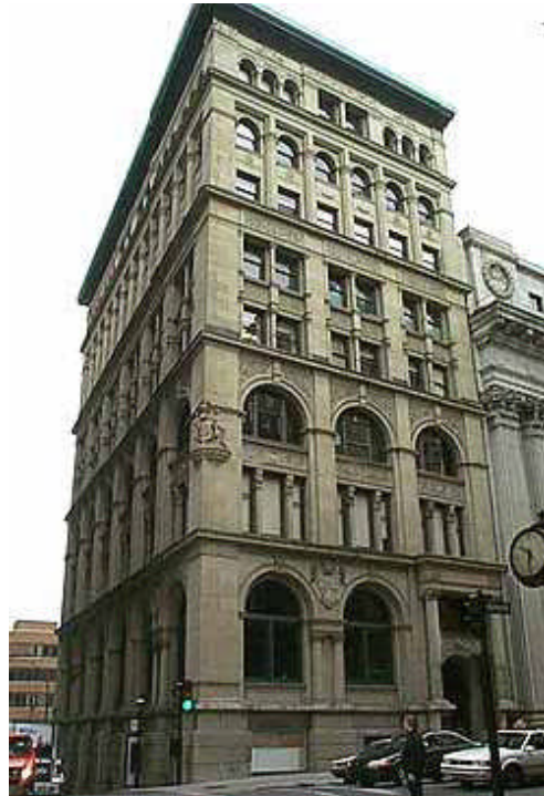
Figure 1.9: 1894, Montréal Canada Life Insurance Building Rue St Jacques 8 étages Ossature murs de maçonnerie porteuse [5]
