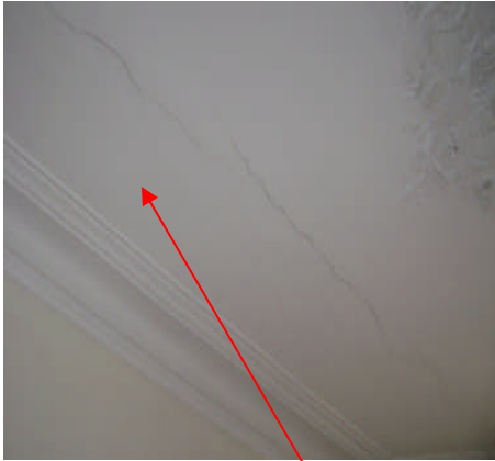
Figure 3.13 : présence des fissures dans les planchers
