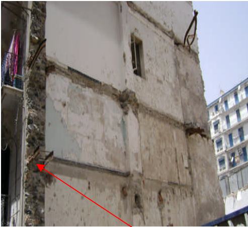
Figure 3.13 : présence des fissures dans les planchers
