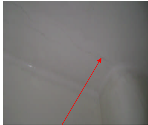
Figure 3.13 : présence des fissures dans les planchers
