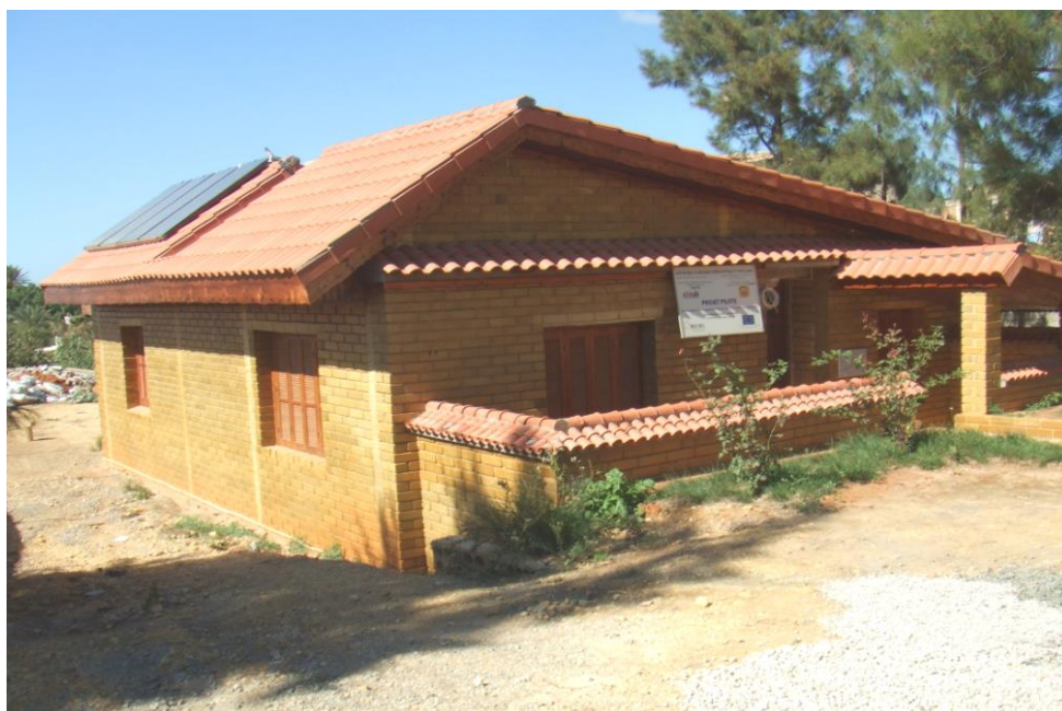
Figure 2.6. La maison prototype situé au CNERIB (à Souidania)
