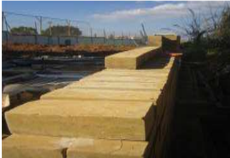
Figure 2.11 : Mur interne (Un panneau de BTS)
