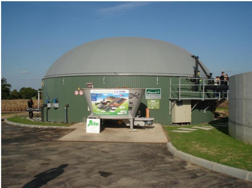
**Figure I.13:** Un digesteur alimenté en continu avec une teneur en MS <5%.
