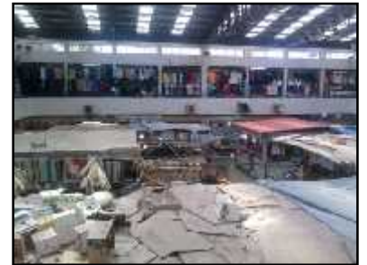
Fig 64 : vue d'intérieur de marché couvert
