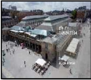
Fig 8 : vue extérieure de Covent Garden
