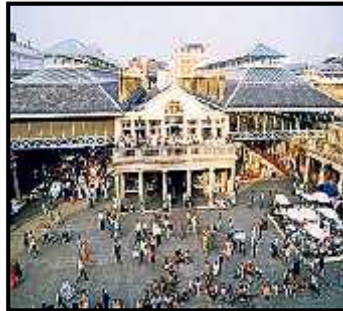
Fig 9 : vue extérieure de Covent Garden
