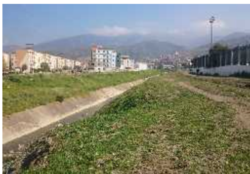
Figure3.48 : Mal exploitation de oued Beni Azza (source: auteur)
