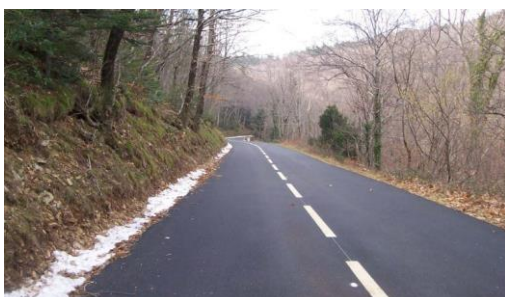
Béton bitumeux émulsion
