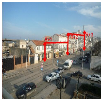
Figure 3.56. Le gabarit des habitations sur Tripoli
