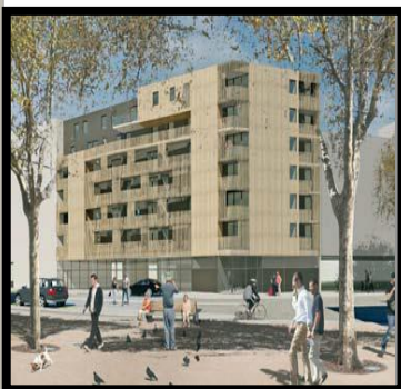
Fig13:MELEZIO : 27 logements avec une activité commerciale au RDC. Sr: http://www.pss-archi.eu/immeubles/FR-
