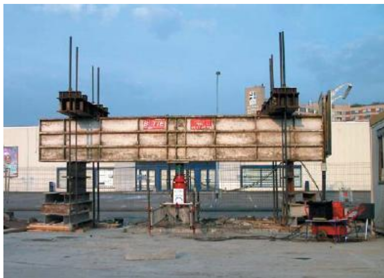
Figure 2.2: Essai de chargement d'un pieu (Montivilliers-France).[22]
