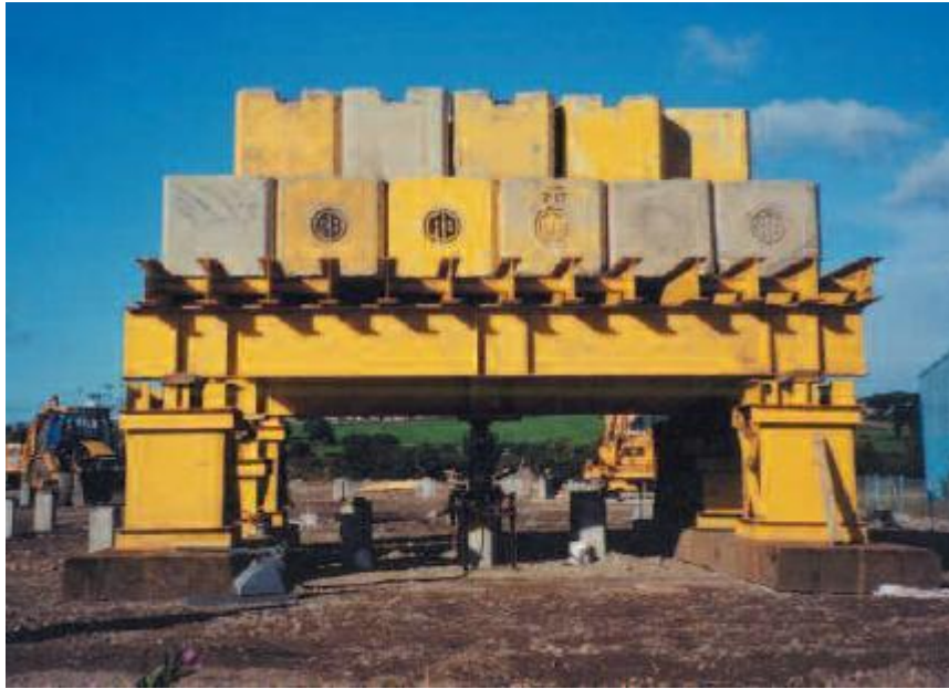
Figure 2.3: Essai de chargement d'un pieu (Belvedere - sud de London) [58]
