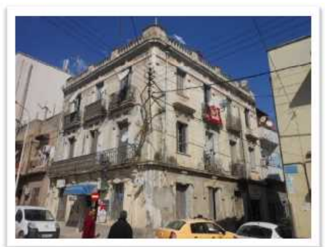
Immeuble ciblé par l'opération pilote de réhabilitation. Quartier de la Colonne
