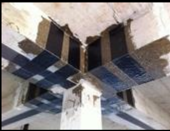
Photo II.3.1 Fibre carbone sous forme de laminés préfabriqués
