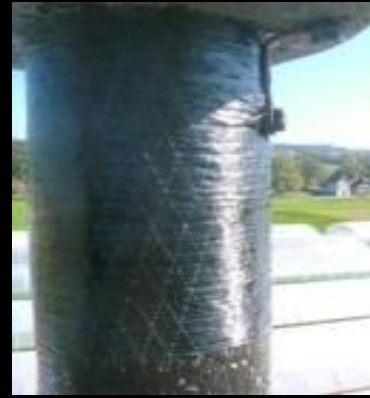
Photo II.3.2 Fibre carbone sous forme de de tissu 400g/m 2
