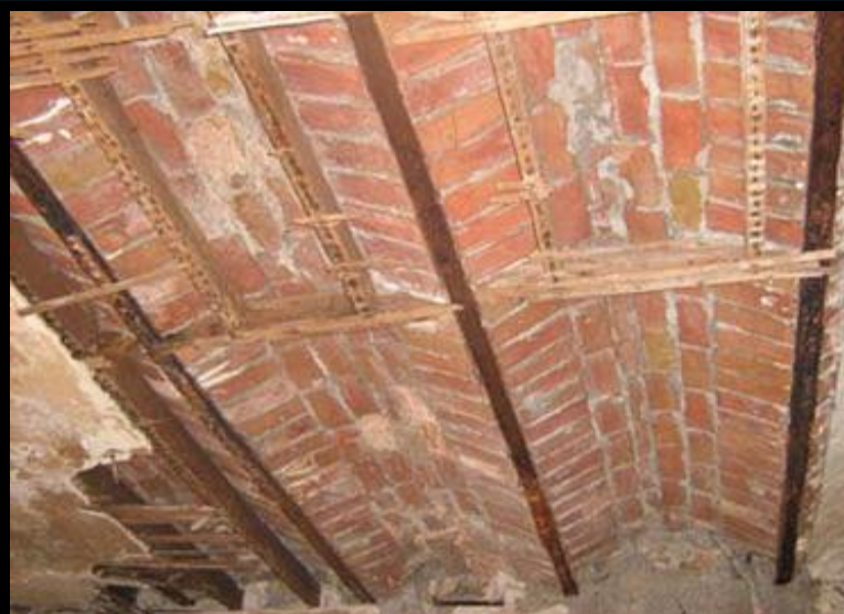
Figure II.1.5 : Plancher à voutain avec brique creuse et faux plafond.
