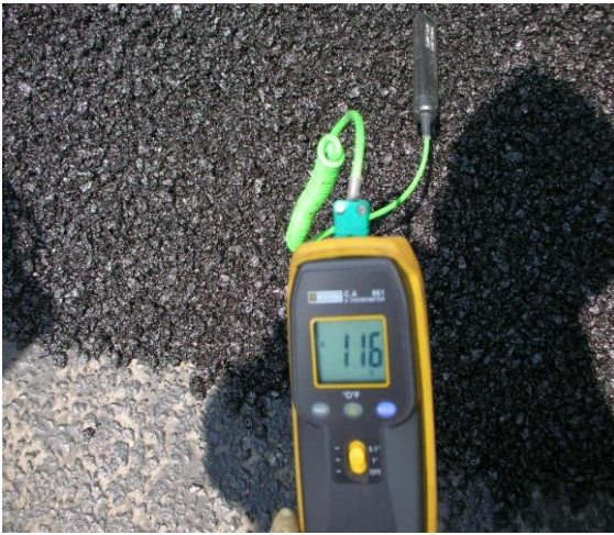
Figure 2.4 : Teste de température d'un enrobé tiède sur chantier [16].
