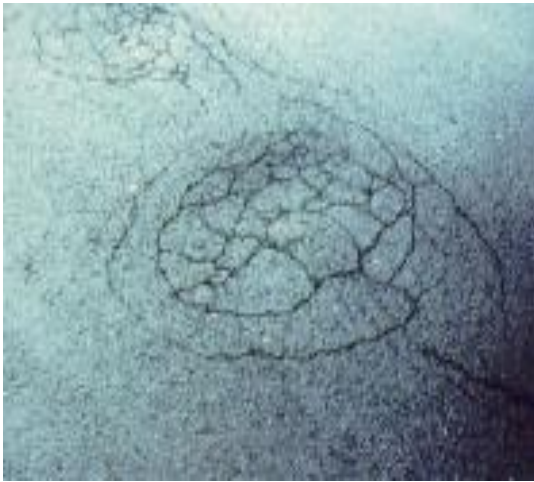
Figure 1.33 : Faïençage circulaire [11].
