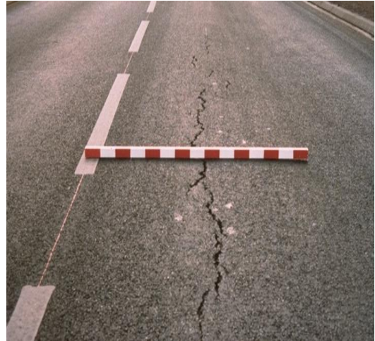
Figure 1.28 : Fissures longitudinales [11].
