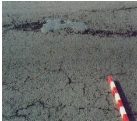
Figure 1.34 : Faïençage dans les bandes de Roulement [11].
