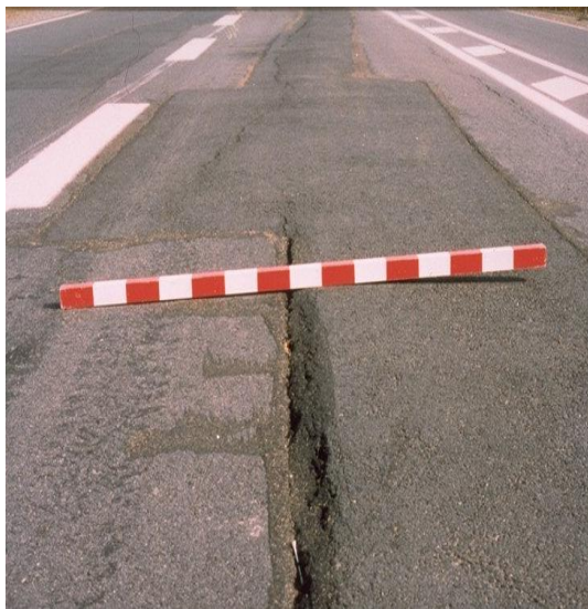
Figure 1.41 : Réparations multiples [11].
