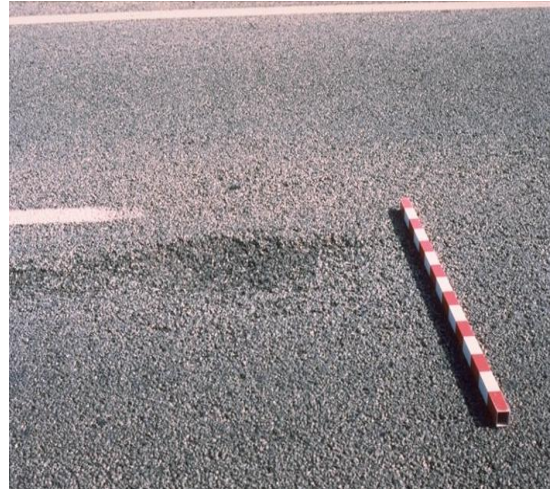
Figure 1.36 : Désenrobage - plumage – Enrobés [11].
