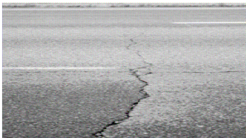
Figure 2.13 : Fissuration thermique.
