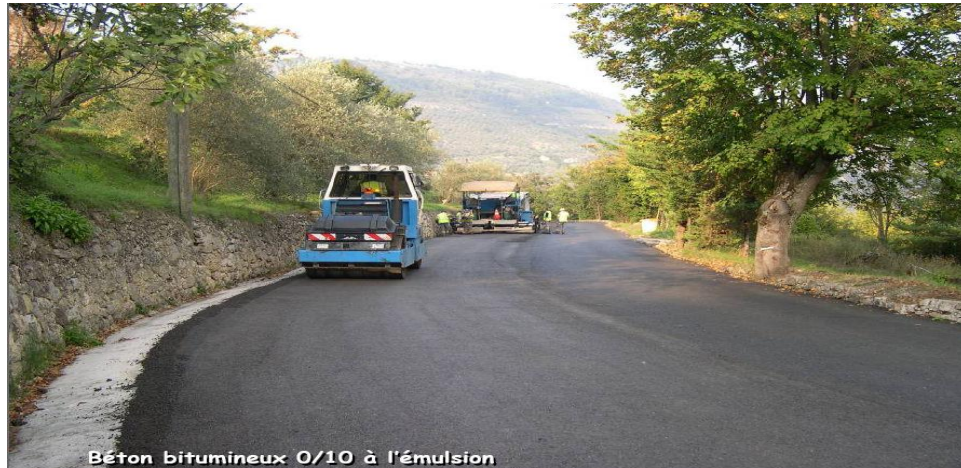
Figure 2.6 : Réalisation d'un enrobé bitumineux à froid sur chantier [19].
