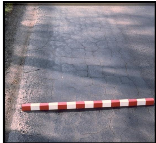
Figure 1.32 : Faiénçage [11].
