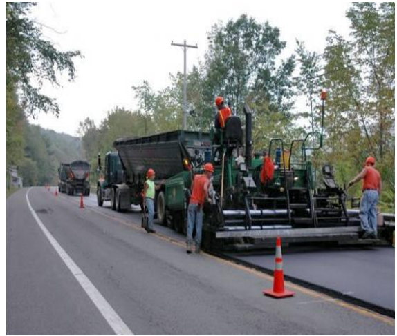
Figure 2.5 : Réalisation des enrobés tiède sur Chantier [16].
