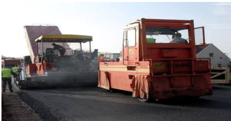
Figure 2.3 : Réalisation des enrobés à chaud sur chantier [12].
