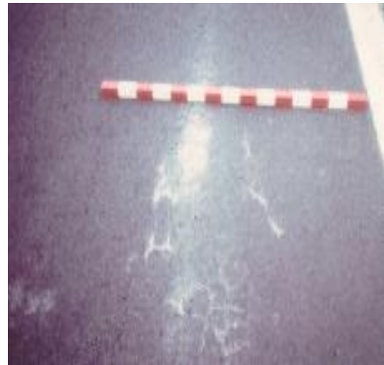
Figure 1.40 : Remontée de fines [11].
