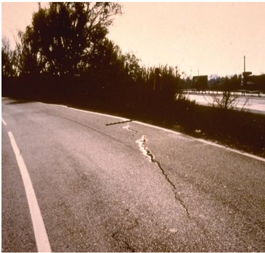
Figure 1.29 : Fissures d'adaptation [11].
