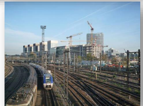
Fig. 12 : La ligne de TGV
