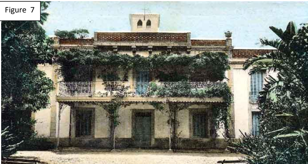
La façade principale du camp
