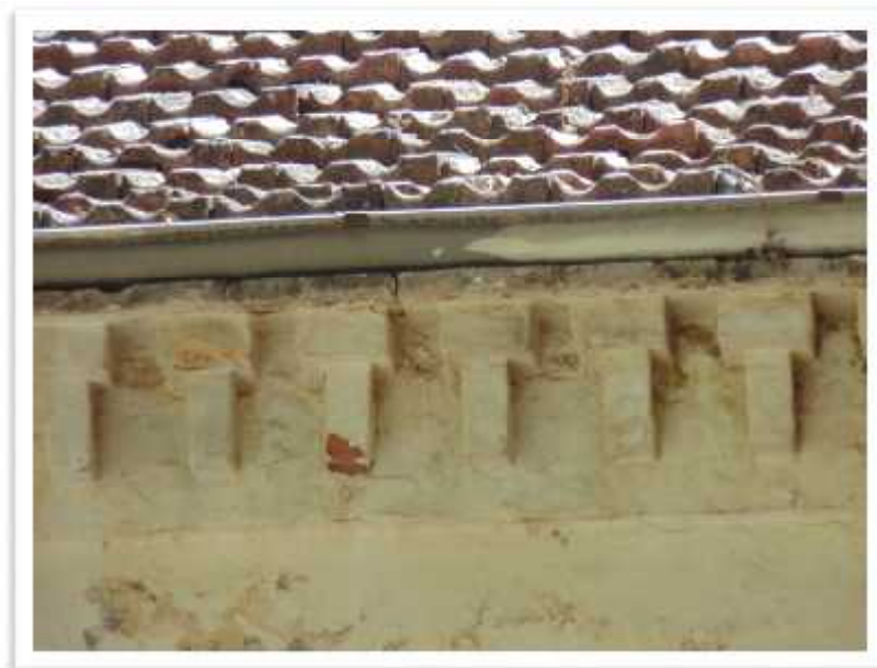
Fig. 3.4. Corniche en brique pleine Modèle 04. Source : Auteur
