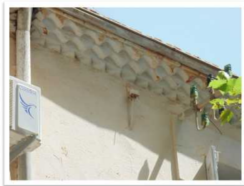
Fig. 3.10. Corniche composite entre la tuile canal et la brique en dents de scie. Modèle 02.
