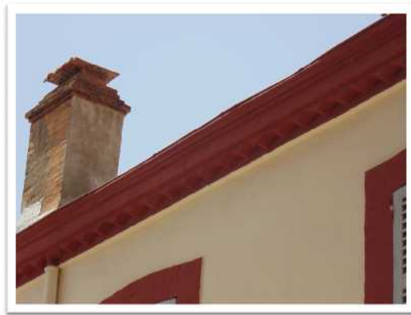
Fig. 3.6. Corniche en tuile canal Modèle 01. Source : Auteur
