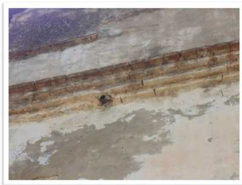
Fig. 3.1. Corniche en brique pleine Modèle 01. Source : Auteur
