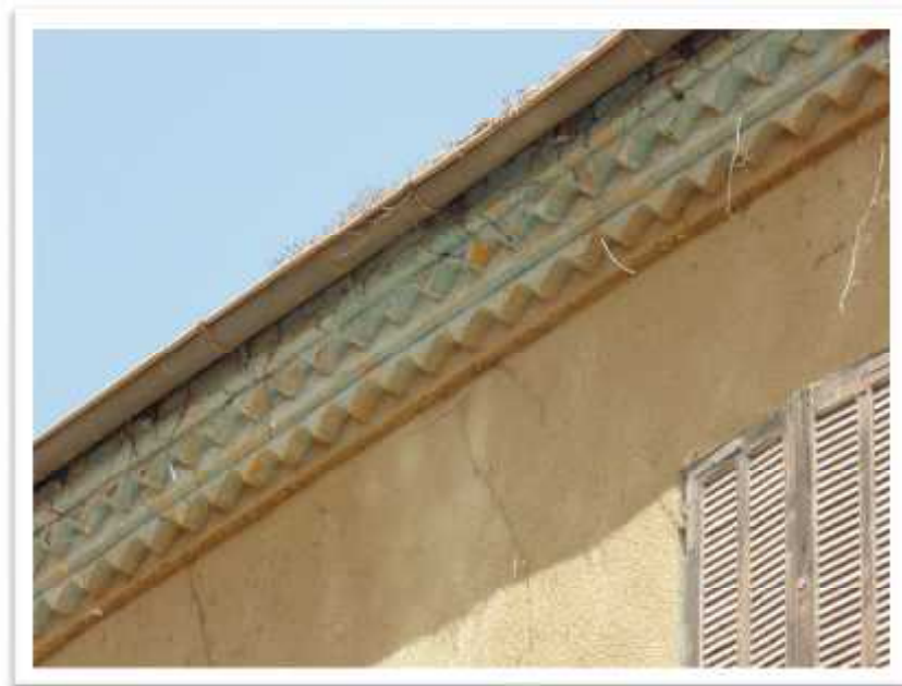
Fig. 3.7. Corniche en tuile canal Modèle 02. Source : Auteur
