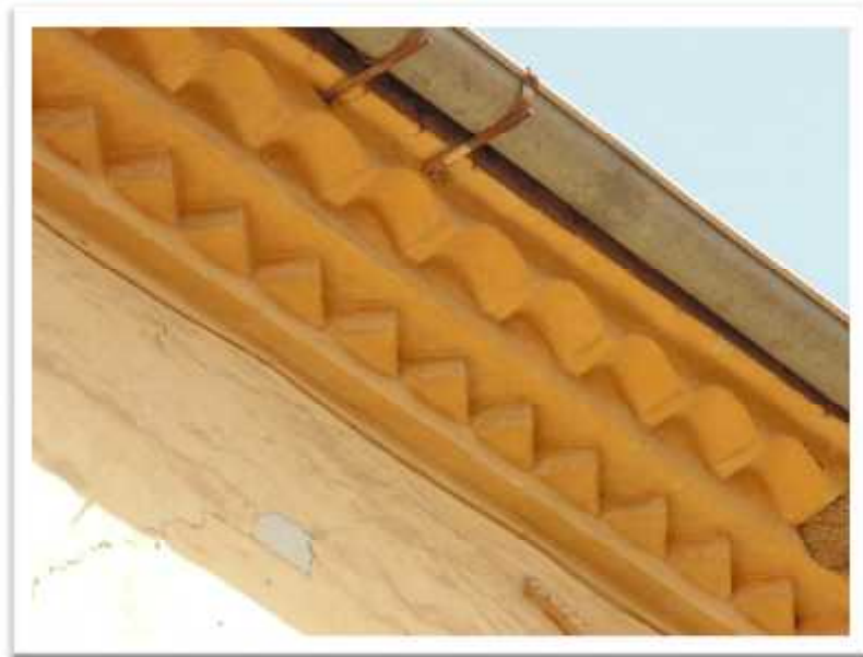
Fig. 3.9. Corniche composite entre la tuile canal et la brique en dents de scie. Modèle 01. Source : Auteur
