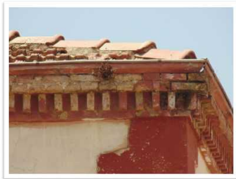
Fig. 3.3. Corniche en brique pleine Modèle 03. Source : Auteur
