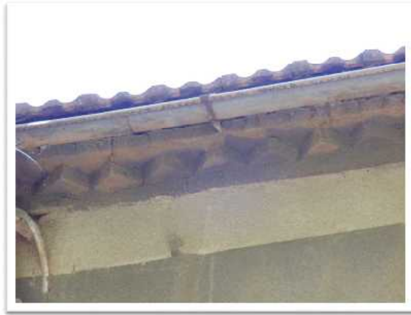
Fig. 3.5. Corniche en brique pleine Modèle 05. Source : Auteur
