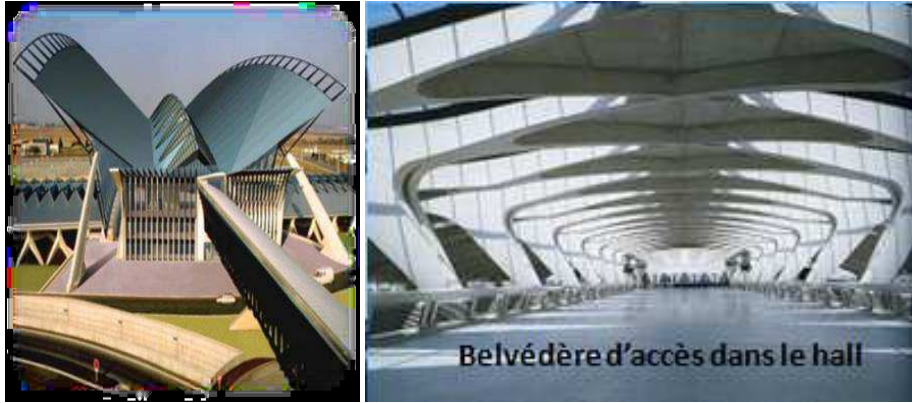
figure: vue sur l'intérieur et l'extérieur de la gare.
