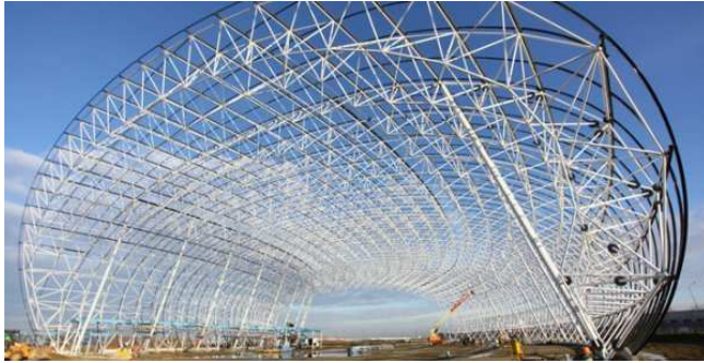
figure: Exemple de construction métallique.
