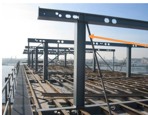
figure 3.60: type de poteau utilisé dans la structure du centre commercial.
