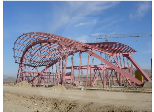
figure 3.62: Le système d'arc utilisé dans la hall d'accueil.
