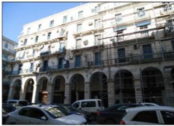
Façade Sud-Est sur le blvd C.AMIROUCHE
