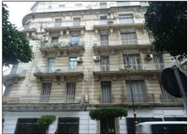
Façade Nord-Ouest; sur l'avenue PASTEUR
