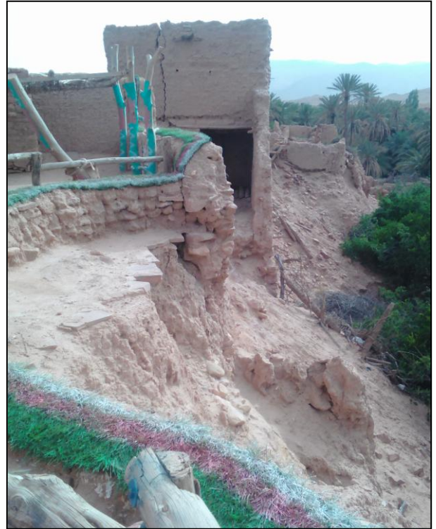
Fig 59 : Vue sur la partie Sud-Ouest du rempart du ksar de Boussemgoune, source image prise par l'auteur 02/2019.
