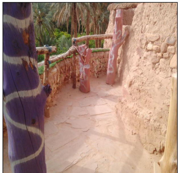
Fig 61 : Vue sur le balcon de l'esplanade du rempart Sud-Ouest de ksar de Boussemgoune, source image prise par l'auteur 02/2019.
