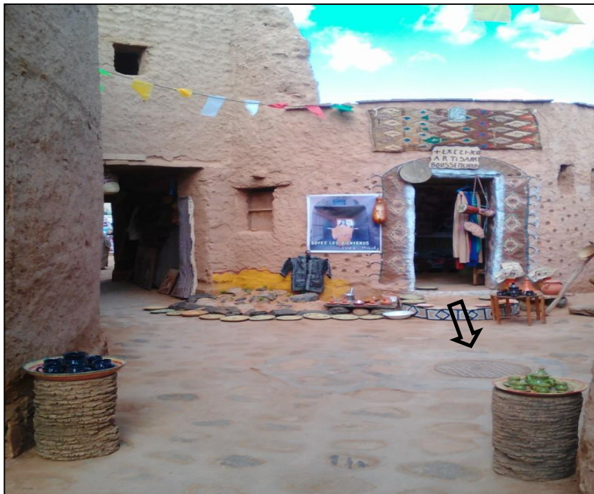
Fig125 : nettoyage et réfection de l'assainissement d'une voie menant vers la zaouïa, source : Image prise par l'auteur 02/2019.
