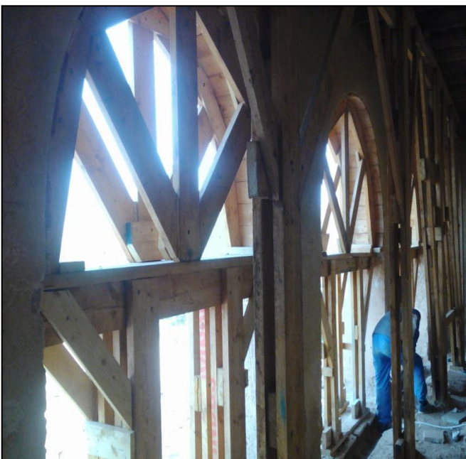
Fig122 : Étalement des arcades du balcon de la khalwa de la zaouïa, source : Image prise par l'auteur 02/2019.
