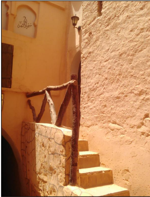
Fig50: L'entrée de la mosquée, source : Image prise par l'auteur 11/2018.
