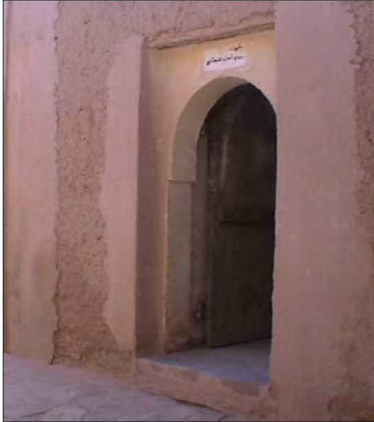
Fig62 : L'entrée de la zaouïa après l'intervention de 2010, source d'image : le Mkadem de la zaouïa.
