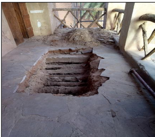
Fig132 : Réalisation de sondage au niveau du balcon de Dar El Baida la zaouïa, source : Image prise par l'auteur 02/2019.
