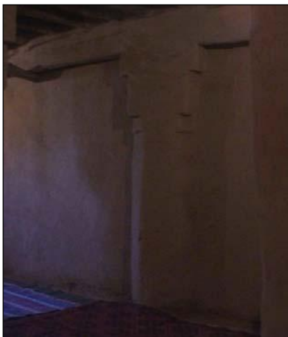
Fig74 : Pilier encastré dans le mur ,source : Image prise par l'auteur 11/2018.
