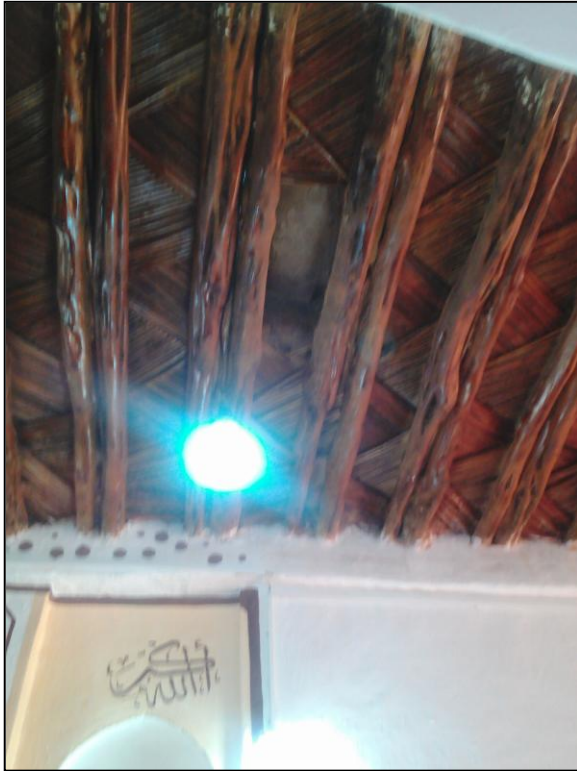
Fig 48 : Le plafond décoré de la salle de prière, source : Image prise par l'auteur 11/2018.
