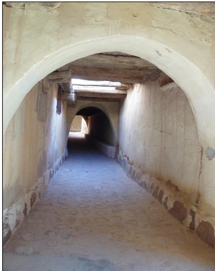
Fig41 : La rue menant à la Zaouïa, source : Image prise par l'auteur 11/2018.
