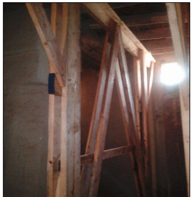
Fig123 : Étalement du Muçala de la zaouïa, source : Image prise par l'auteur 02/2019.
