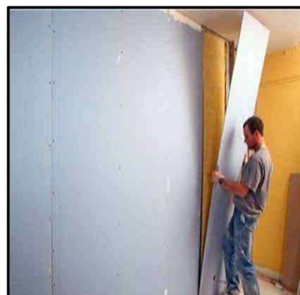
**Figure 157 :** Le Placoplâtre (Source : <https://www.lemagdestravaux.com/> )
