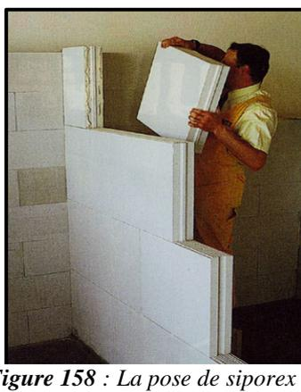
**Figure 158 :** La pose de siporex (Source : <https://www.lemagdestravaux.com/>)
