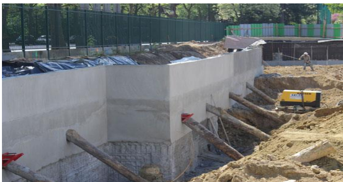
Figure IV-36 Image illustrative d'un mur de soutènement en construction, source Google image
