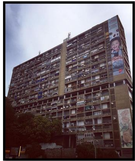
Figure III-22 Façade moderne, source auteur, année 2019
