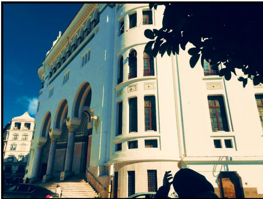
Figure III-15 La grande poste façade néo mauresque, source auteur, année 2019
