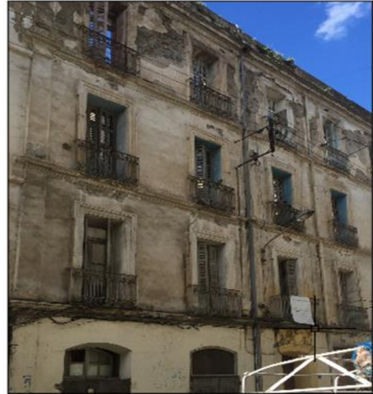
Figure III-28 Façade étudiée, source auteur, année 2019
