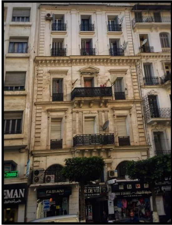
Figure III-11 Façade Néo-Classique 02 rue Laarbi Ben M'hidi, source auteur ,année 2019
