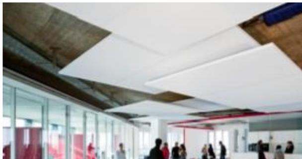
Figure 108 : Panneaux acoustique Eco-phon Solo
