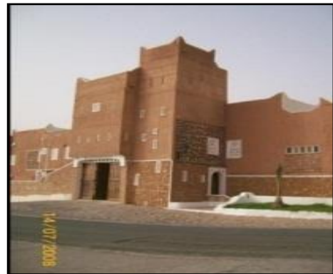
Figure 18 : Entrée urbaine de ksar Tafilalet. Source: Google image.
