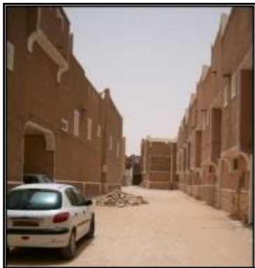
Figure 25 : La voiture intègre le ksar. Source : http://tafilelt.com/site .
