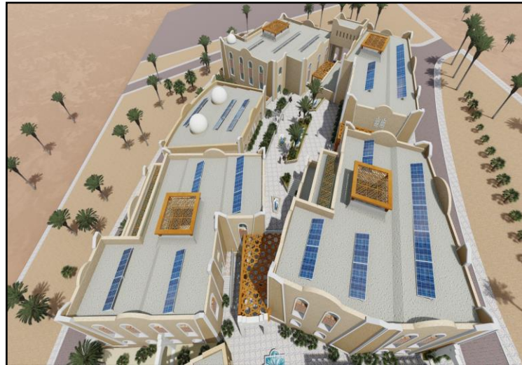
Les panneaux solaires sur les toitures. Source : auteur
