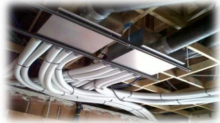
**Figure 23 :** Centrale double flux et les Gaine PEHD.
