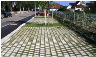
Figure189 : pavé en béton drainant. source: http://www.hexastone.fr/produit-ba-ton-drainant-c-24.html?famille_id=24
