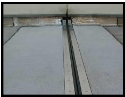
Figure 152: joint de dilatation. source: https://www.batiproduits.com/fiche/produits/joint-de-dilatation-en-aluminium-pour-parcs-de-sta-p69058563.html
