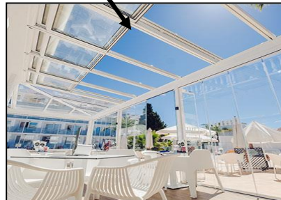
Figure200: toiture amovible. source: auteurs.
