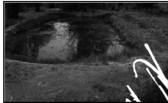
Fig.2.8 : un madjen (bassin de stockage) dans une palmerais de Timimoun (remini, 2008) Source : article revue des sciences de l'eau (REMINI 2010)
