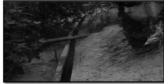
Fig.2.7 : seguia classique d'une Foggara classique dans une palmerais à Timimoun (REMINI 2007) Source : article revue des sciences de l'eau (REMINI 2010)
