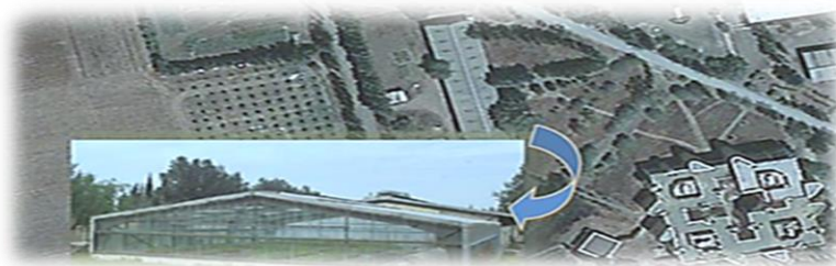
Figure 11 : la serre et la station par GPS (Google Earth, 2020)
