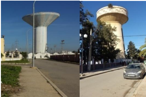
Figure 102: les deux châteaux d'eau
