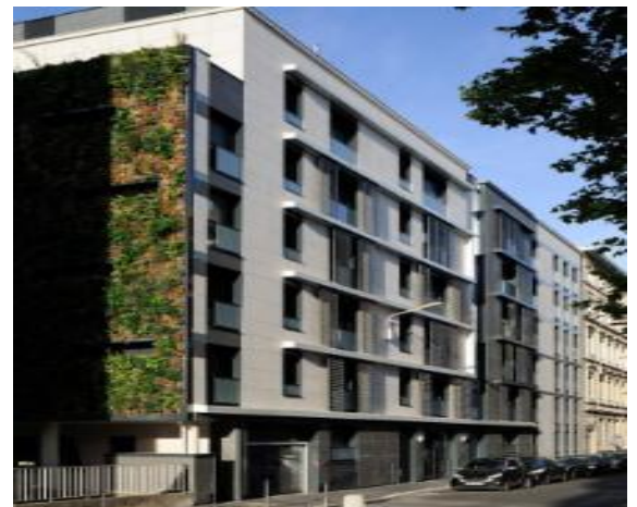
Figure II.33 : un mur pignon Est transformé en jardin vertical, source : https://www.pinterest.fr/pin/681591724824590845
