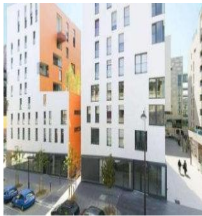
Figure II.24 : L'alignement des bâtiments sur la voie, source : le livre L'îlot ouvert Christian Portzamparc « paris rive gauche ».
