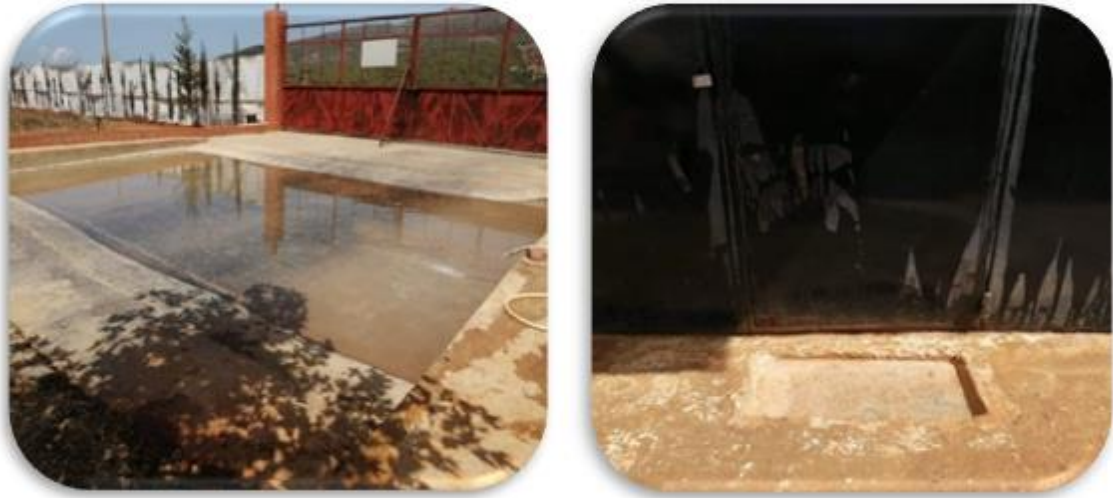
Figure 13 : pédiluve pour les grandes machines et pour les gens étrangères source : nous-même 2020.
