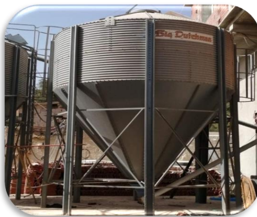
Figure 14 : système de stock d'alimentation (silo) source : nous meme.2020.
