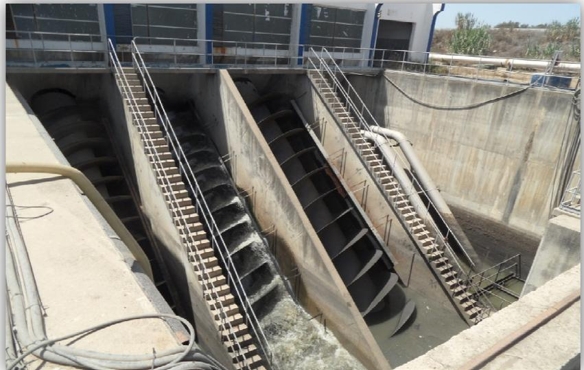
**Figure 13** : Poste de relèvement PR1 (photo originale)
