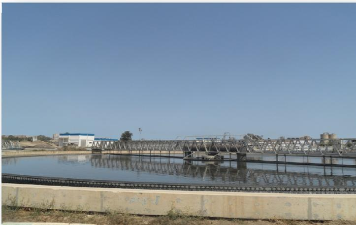
**Figure 21 :** Clarificateur (bassin de décantation)
