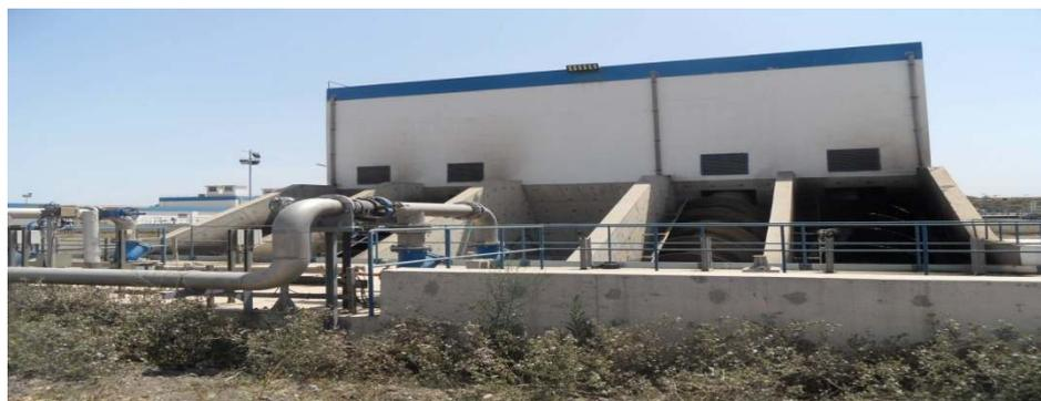
**Figure 22 :** Poste de recirculation des boues
