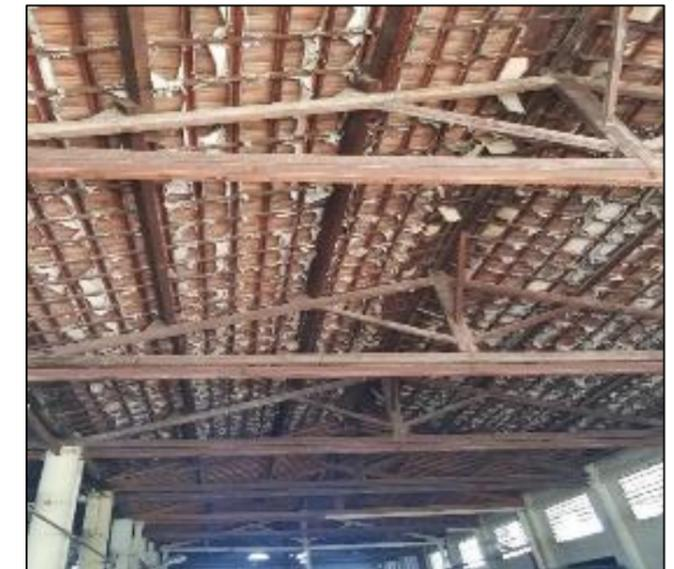
Figure 81 : Structure (charpente en bois et poteaux en béton).
