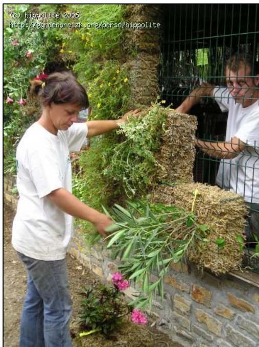
Figure 1.20: Mise en œuvre du Substrat
