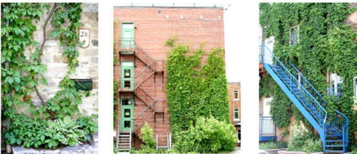
Figure 1.2 : Murs végétaux simples de façade
