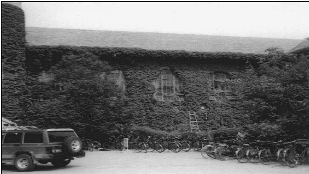
Figure 1.24: Vue Ouest de la bibliothèque d'université de Tsinghua
