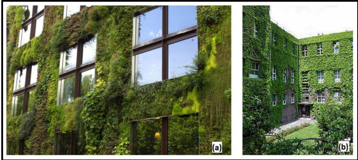
Figure 1.7: Exemples de façades végétalisées : (a) Mur végétal du musée du quai de Branly; (b) Façades végétales grimpantes du CHU de Leipzig dans la Saxe en Allemagne
