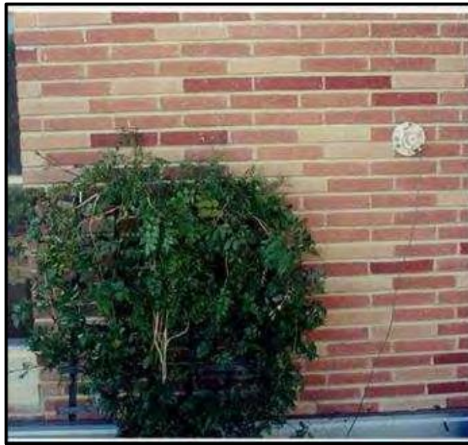
Figure 1.31: Vigne de Campsis sur un mur sud de brique
