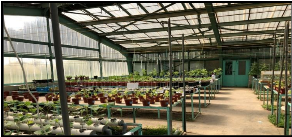
Figure N°26 : La serre en polycarbonate de l'intérieur (Originale, 2020).
