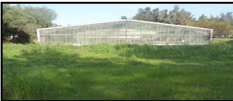
Figure N°27 : La serre en polycarbonate de l'extérieur (Originale, 2020).
