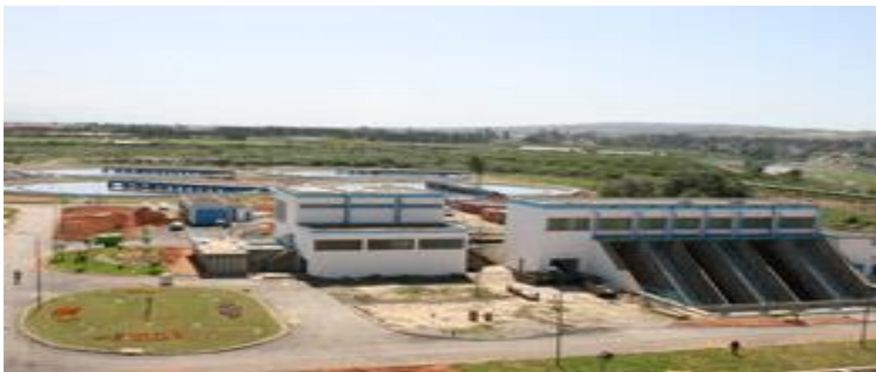
Figure12 : Station d'épuration des eaux usées de Baraki (SEAAL, 2018)
