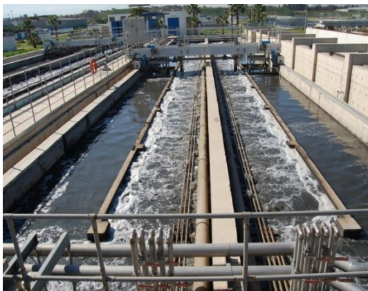
Figure 5 : L'ouvrage dessableur-déshuileur (STEP de Baraki (SEAAL, 2018))
