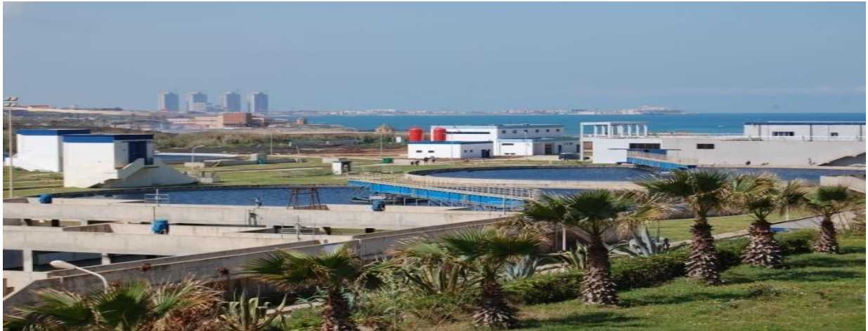
Figure 13: Station d'épuration des eaux usées d'Ain benian (SEAAL, 2018).
