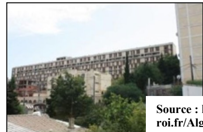
Réaménagement de la cité Sellier
