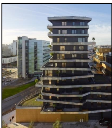
Figure 43 : Le bâtiment principal du projet INOXIA.
