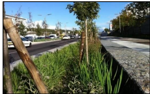
Figure 75 : Exemple de réalisation de voirie avec noues plantées attenantes
