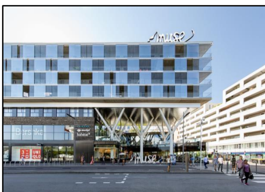
Figure 50 : Façade principale de MUSE.
