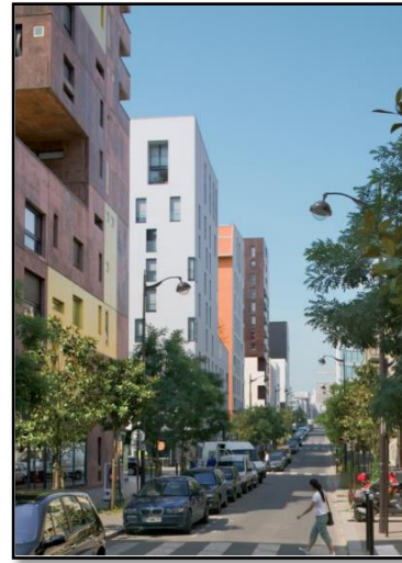
Figure 38 : l'alignement des bâtiments Source : www.christiandeportzamparc.com/fr/projects/quartier-
