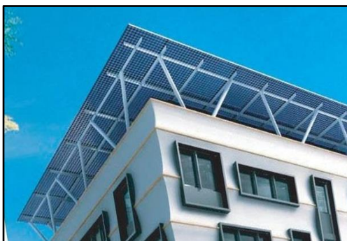
Figure 66 : les volets thermiques.
