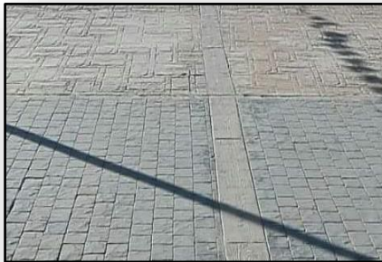
Figure 23 : Traitement du sol sur la place des martyres Source : photo prise par l'auteur
