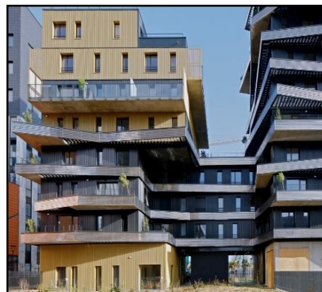
Figure 44 : le second bâtiment du projet INOXIA.
