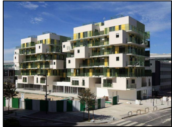
Figure 99 : 27 logements sociaux récemment sortis de terre dans la Zac Fauvelles de Courbevoie (Hauts de Seine).
