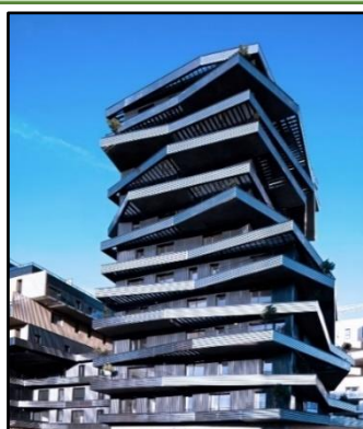
Figure 45 : Façade du bâtiment principal de INOXIA.
