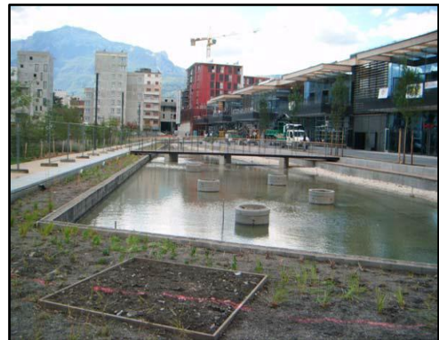
Figure 73 : Bassin servant de récupération des eaux de pluie, d'agrément paysager, et de stockage d'eau d'arrosage
