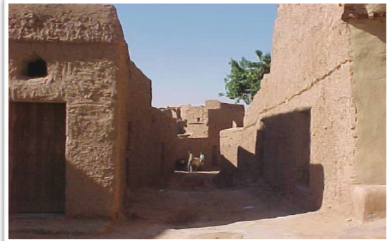
Darb (rue centrale) Ikhrizam
