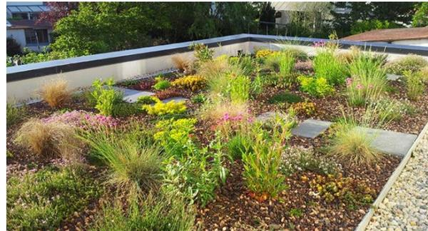
Figure 131 : Toiture végétalisée extensive
