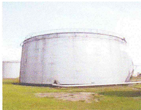
Figure : un réservoir de stockage
