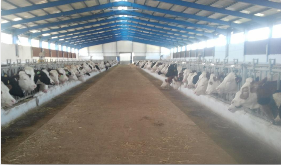
Figure : Bâtiment des vaches laitières en production (stabulation semi-entravée)
