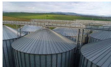
Figure n°11 : silos de stockage
