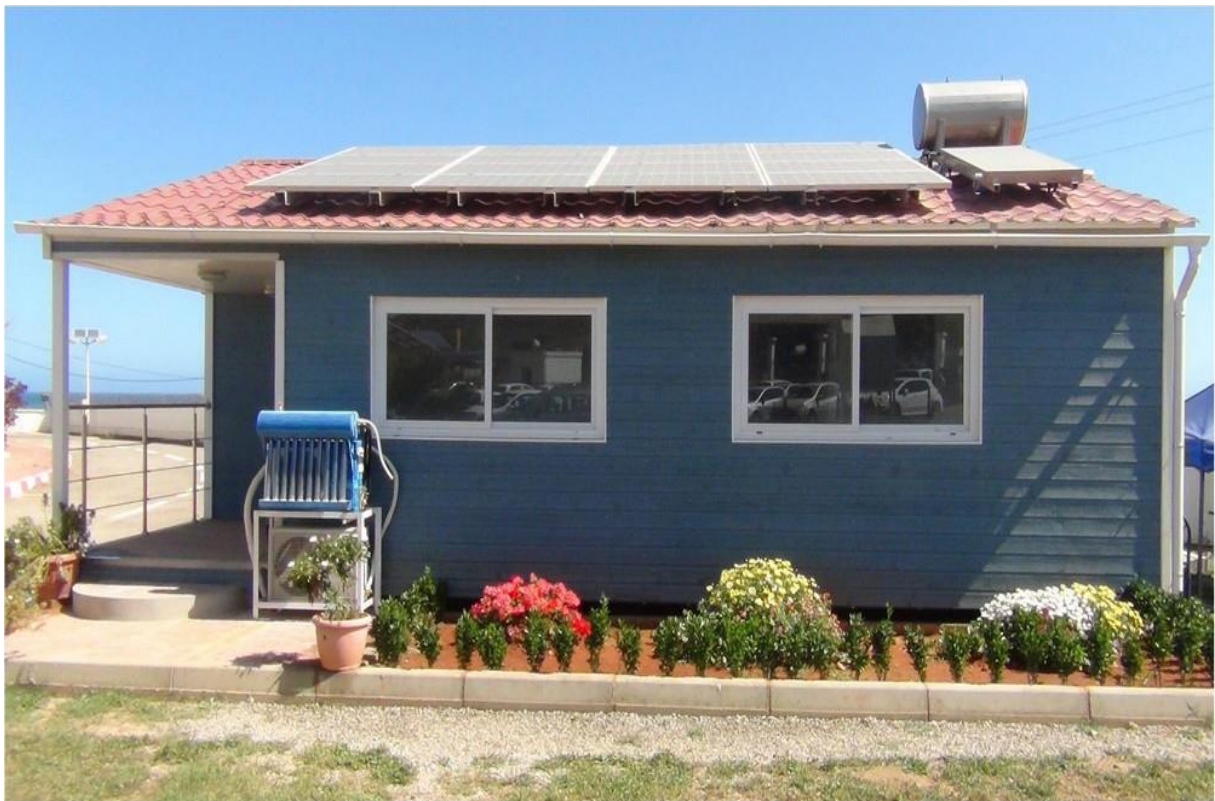
Figure II.2 : Maison solaire située à l'UDES (Bou-Ismaïl)
