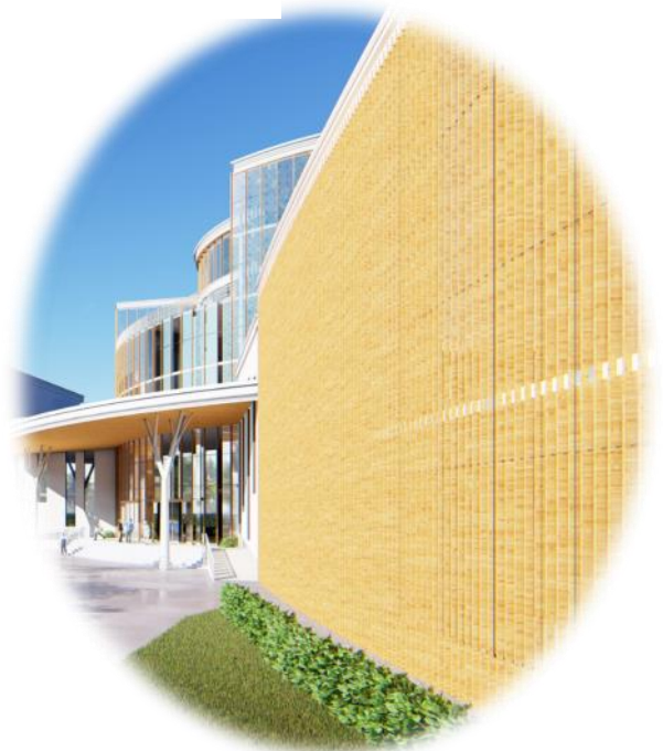
Figure 75: façade double peau Source : auteur
