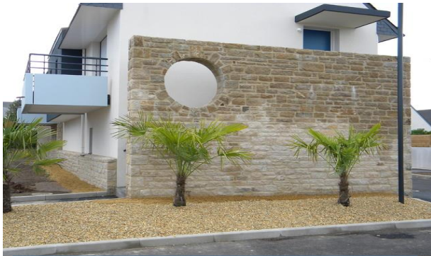
Figure 18: photo enveloppe en pierre 1
