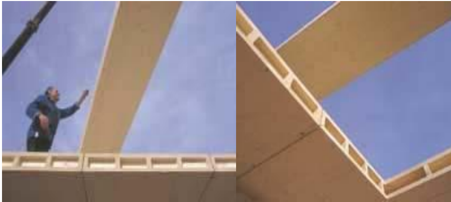
Figure 90: plancher a caisson en bois
