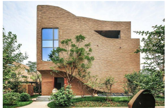
Figure 19: photo enveloppe en pierre 2
