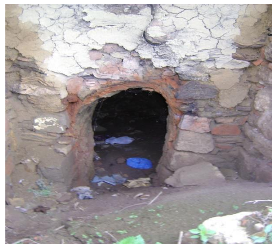
Figure 50 : les ilots de la vielle ville de Mila ,source : auteur
