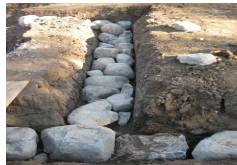
Figure11: image fondation en pierre 2
