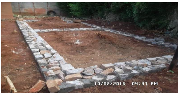
Figure10: image fondation en pierre
