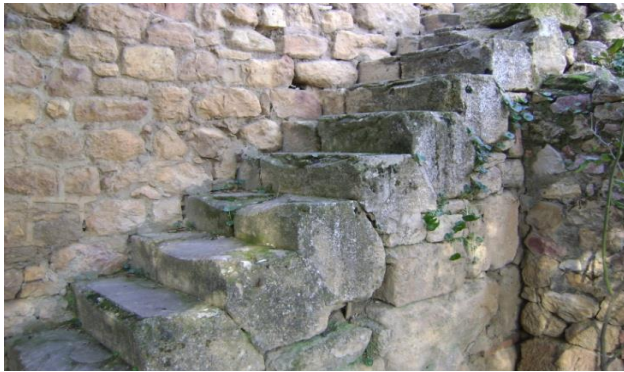
Figure7: bloc état brut.(Mila)
