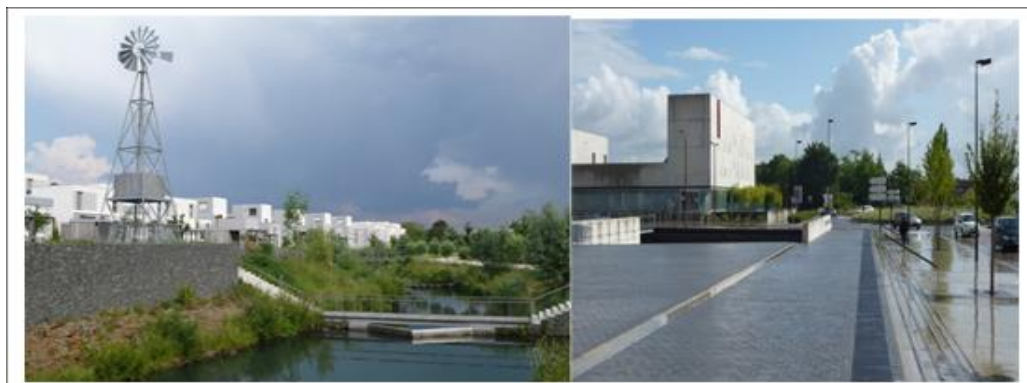
Image 19 : vue de la place et les réservoirs de stockages.
