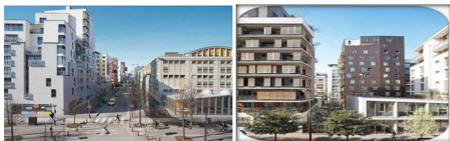
Image 11 : Alignement sur la voie.
