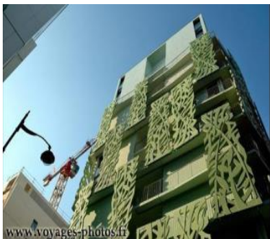
Image 16 : Aspect végétale aux façades.
